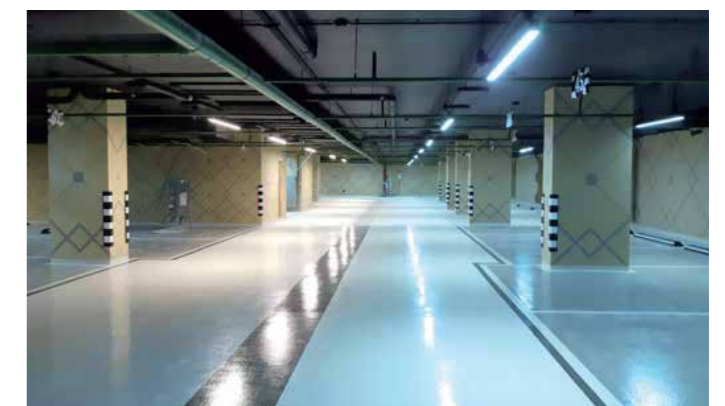
Паркинг ЖК Реномэ Москва, Sikafloor®-1324 R/1324 (MasterTop 1324 R/1324)
