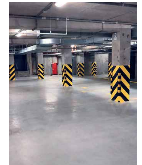
ЖК Паруса, Санкт-Петербург, Sikafloor® SynTop-450 (MasterTop 450)
